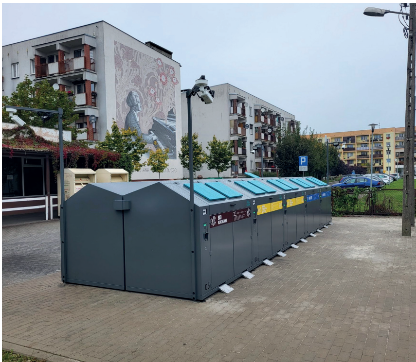
Zdjęcie 3. Urządzenia do zbiórki odpadów wyposażone w elektronikę dostępową, pomiarową i kamery monitoringu.
