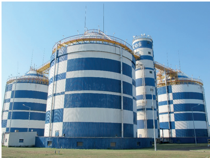
Rys. 5.1. Komory fermentacyjne osadów ściekowych
