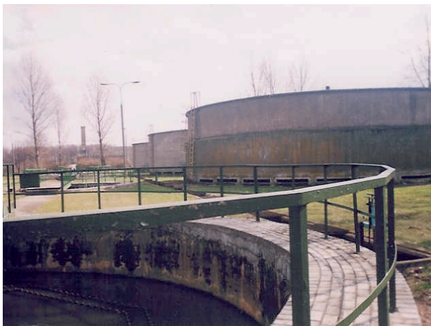
Rys. 11.6. Fragment osadnika wtórnego radialnego oraz złoża biologiczne
