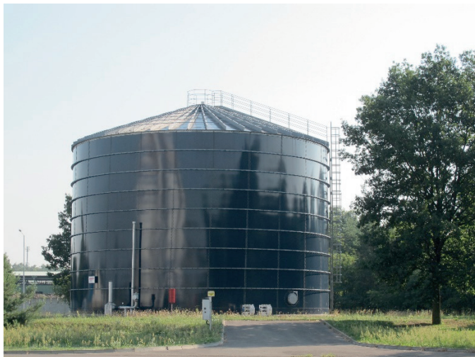
Rys. 5.2. Zbiornik biogazu
