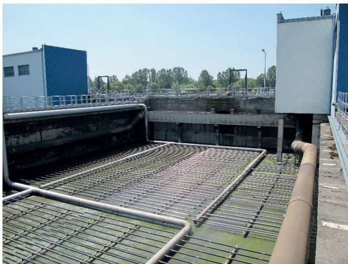
Rys. 11.4. Komora biologiczna osadu czynnego z systemem napowietrzającym
